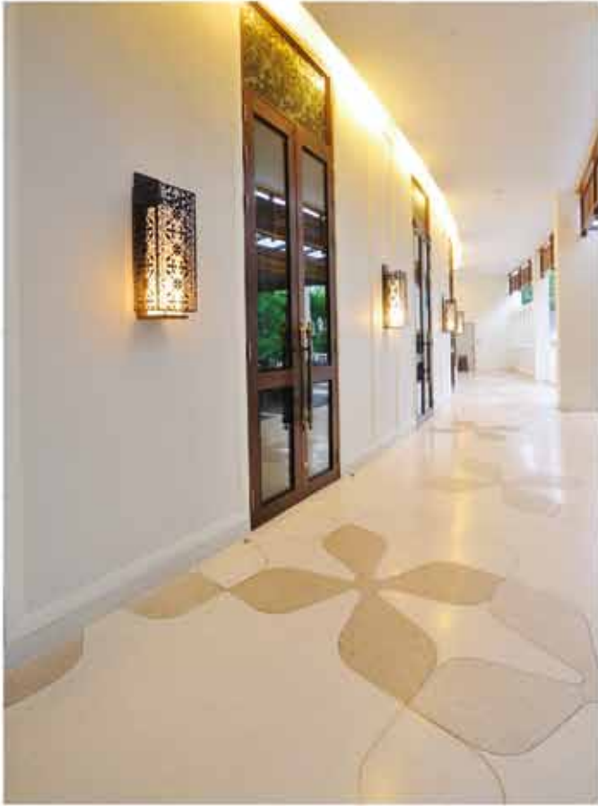
ระเบียบเทอราซโซ่ในโซนนี้ได้อย่างอิสระต่อเนื่องเป็นผืนเดียวกัน
