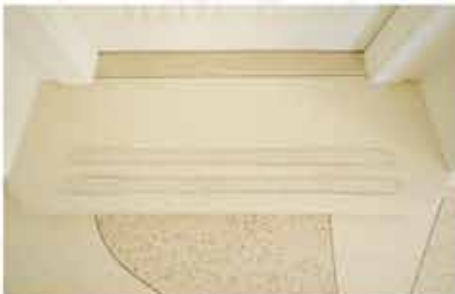
แท่นโถงราชโศภายใช้หินกรีตขนาดต่างกันกับลวดลายกราฟิกของพื้นระเบียง
