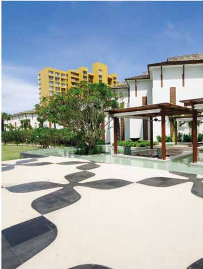
กรวดล้างบริเวณ out door ในรูปกราฟิกที่ต่อเนื่องจากภายใน
