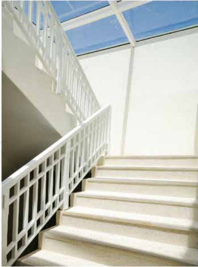
บันไดเทอร์ราซโซสร้างความสะดวกต่อเนื่องกับพื้นทางเดินเข้าห้องพัก
